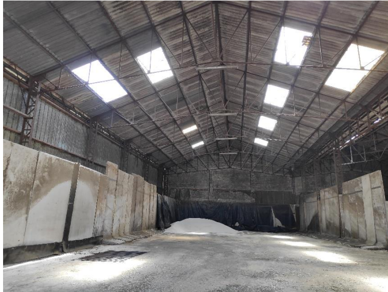
Vue intérieure d'un hangar
